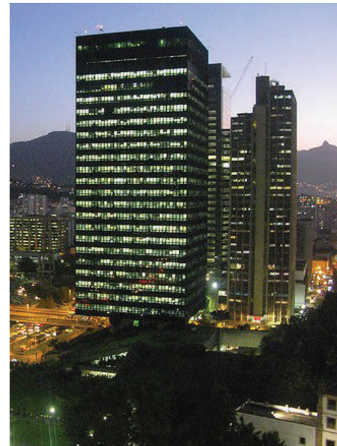
Edificio sede del BNDES, Río de Janeiro.
